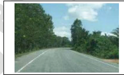
กม. ....๕. + .....๕๐๐.....(สภาพสายทางโดยทั่วไป)
