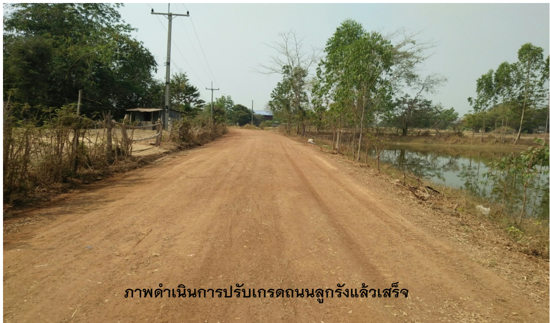
ภาพดำเนินการปรับเกรดถนนลูกรังแล้วเสร็จ
