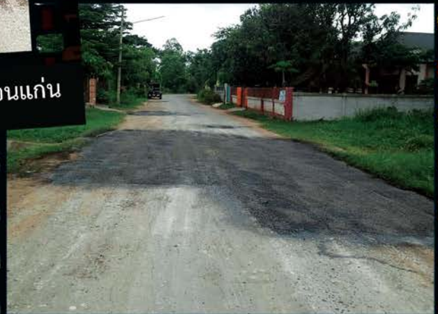
ถนนสาย บ.นางาม - บ.หินแตก อ.มัญจาคีรี
