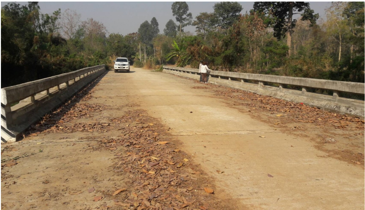
ภาพความกว้างสะพาน
