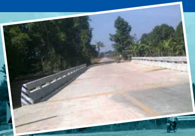
สร้างสะพานคอนกรีตเสริมเหล็ก ท่อเหลี่ยมคอนกรีตเสริมเหล็ก และวางท่อระบายน้ำคอนกรีตเสริมเหล็ก
