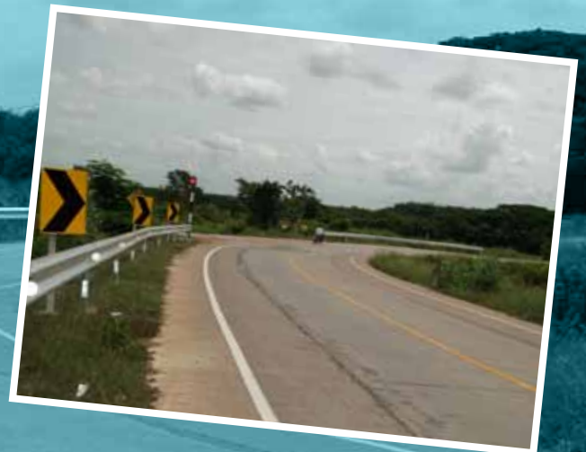
งานเสริมความปลอดภัยในถนน
