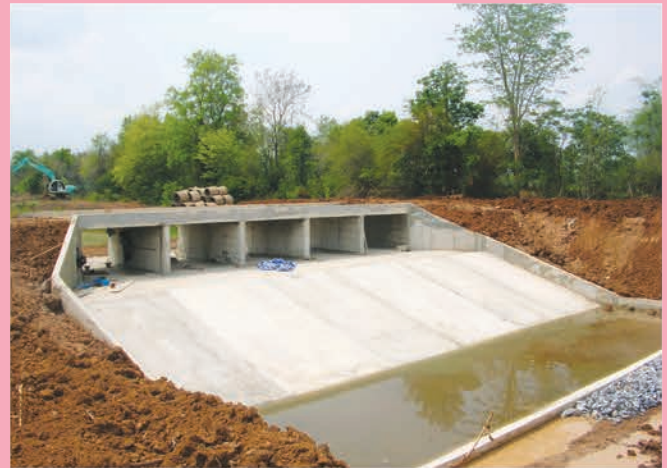
โครงการก่อสร้างท่อเหลี่ยมคอนกรีตเสริมเหล็ก ในเขตพื้นที่ 1 อำเภอ จำนวน 1 โครงการ
