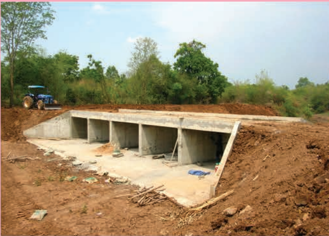
โครงการก่อสร้างท่อเหลี่ยมคอนกรีตเสริมเหล็ก ในเขตพื้นที่ 1 อำเภอ จำนวน 1 โครงการ
