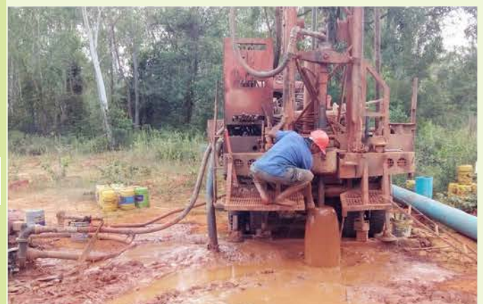
เจาะบ่อบาดาล
