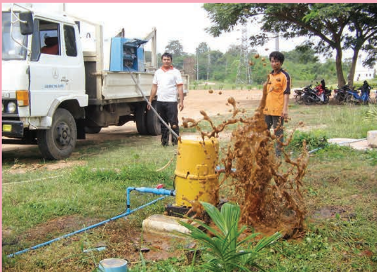
พัฒนาบ่อบาดาล เป่าล้างบ่อบาดาล ตามแผนปฏิบัติการประจำปีงบประมาณ 2558 จำนวน 150 บ่อและเป่าล้างบ่อบาดาลนอกแผน (ตามที่ประชาชนร้องขอ) จำนวน 51 บ่อ รวมทั้งสิ้น 202 บ่อ ในเขตพื้นที่ 26 อำเภอ
