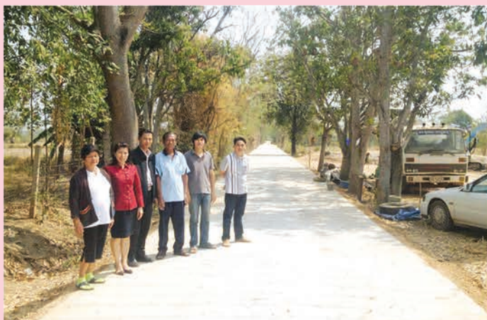
โครงการก่อสร้างถนนคอนกรีตเสริมเหล็ก เชื่อมระหว่างหมู่บ้าน ตำบล และอำเภอ ใน 15 อำเภอ จำนวน 48 โครงการ
