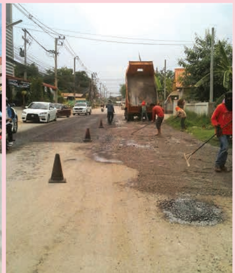
งานซ่อมปะหลุมบ่อถนนลาดยาง (งานทำเอง) รวมพื้นที่ 29,070 ตร.ม.
