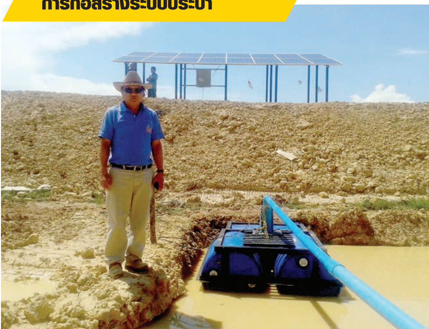
การก่อสร้างระบบประปา
