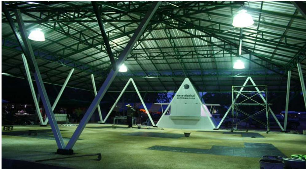
ก่อสร้างอาคารแสดงโชว์งู
