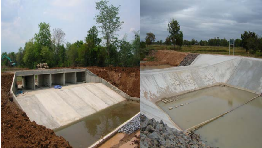
ก่อสร้างท่อเหลี่ยม / ก่อสร้างถนนน้ำล้นผ่าน
