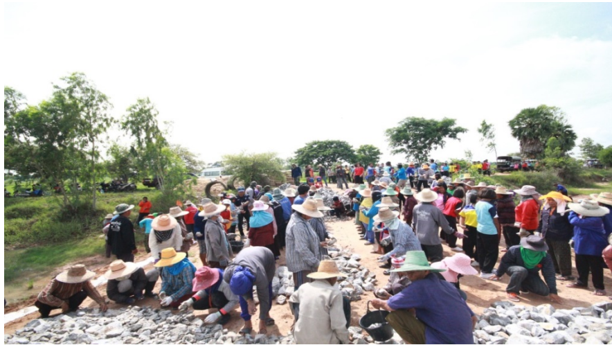
โครงการก่อสร้างฝายชะลอน้ำ(ฝายหินทิ้ง)
