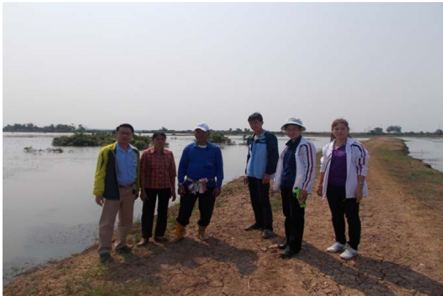
โครงการก่อสร้างพังกันน้ำ
