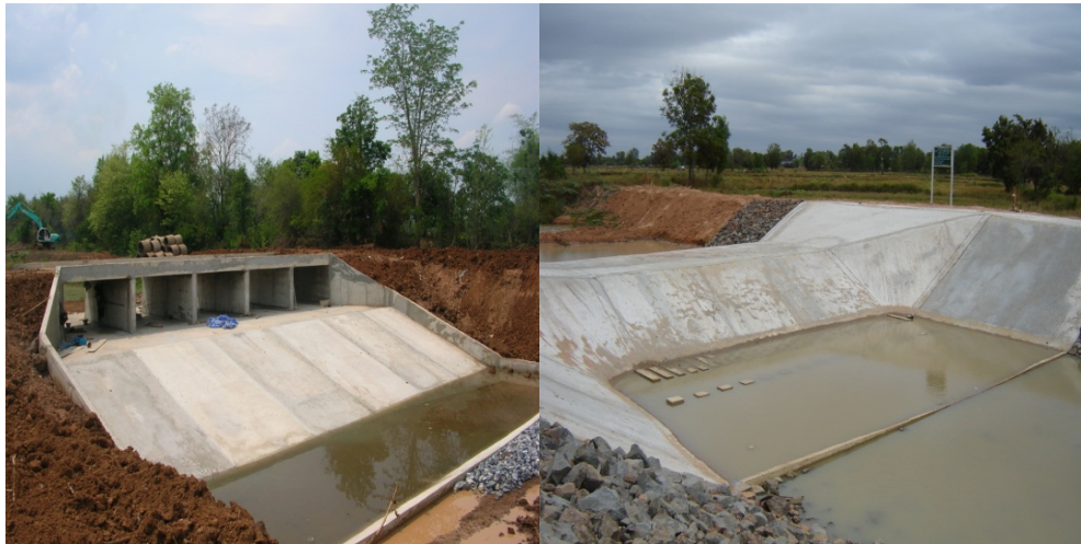
ก่อสร้างท่อเหลี่ยม / ก่อสร้างถนนน้ำล้นผ่าน
