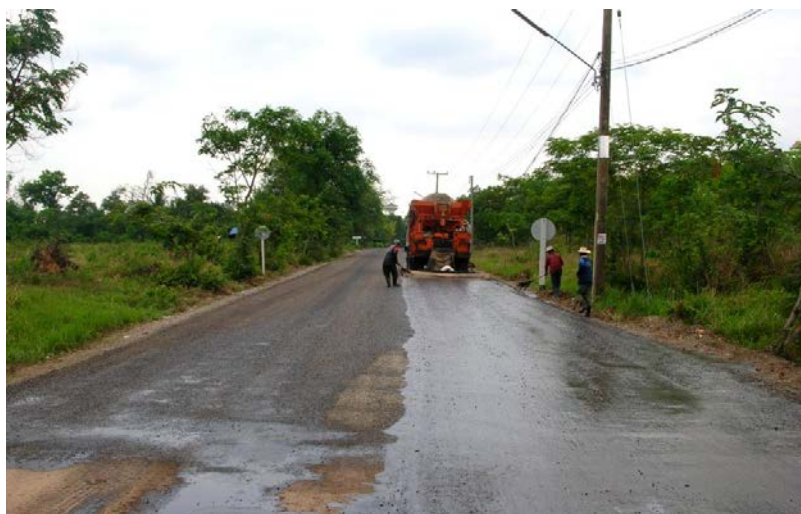
โครงการก่อสร้างถนนลาดยาง
