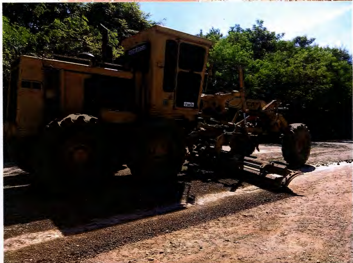
โครงการปรับปรุงถนนลาดยางแอสฟัลต์คอนกรีต
