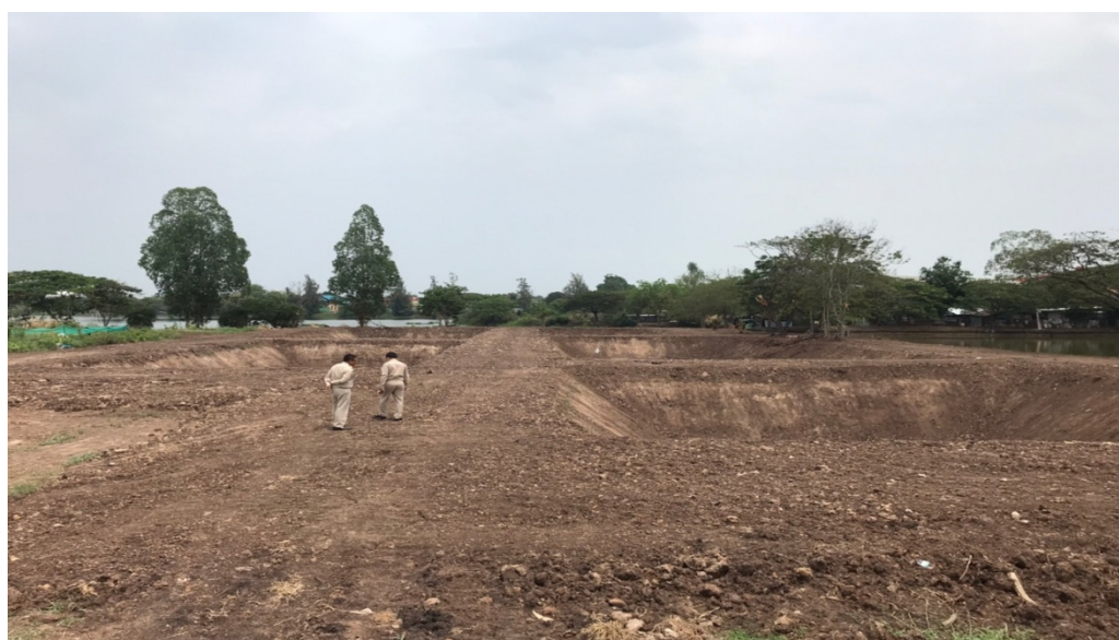
บ่อบำบัดน้ำเสียที่ดำเนินการขุดแล้วเสร็จ จำนวน 5 บ่อ
