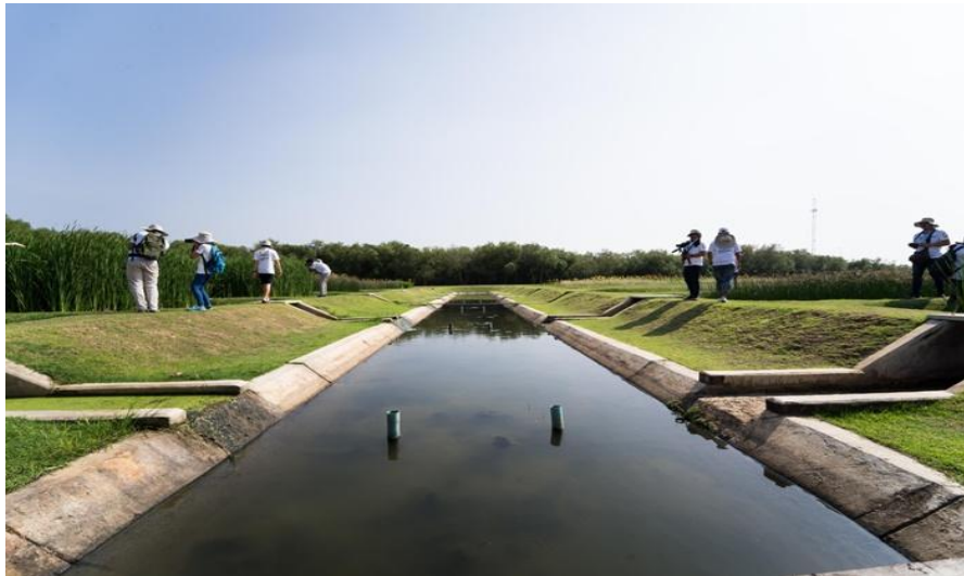
บ่อบำบัดน้ำเสีย
