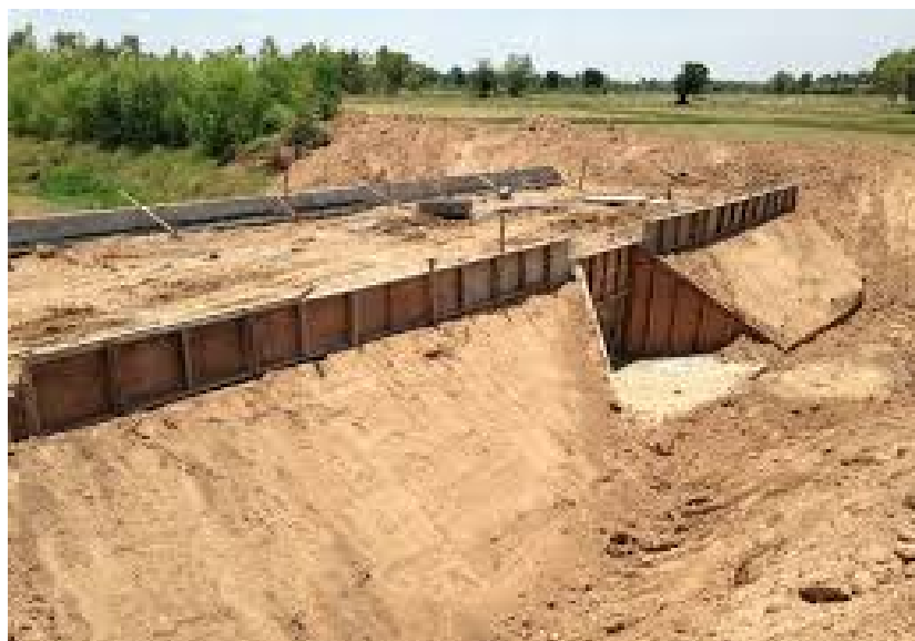
ภาพที่ 1 กำลังดำเนินการก่อสร้างถนนสำหรับน้ำล้นผ่าน
