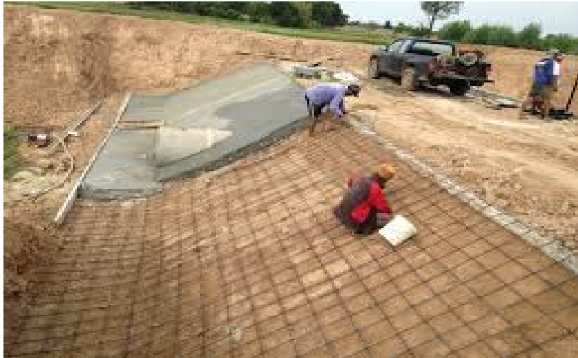
ภาพที่ 2 กำลังดำเนินการการก่อสร้างตาดคอนกรีต
