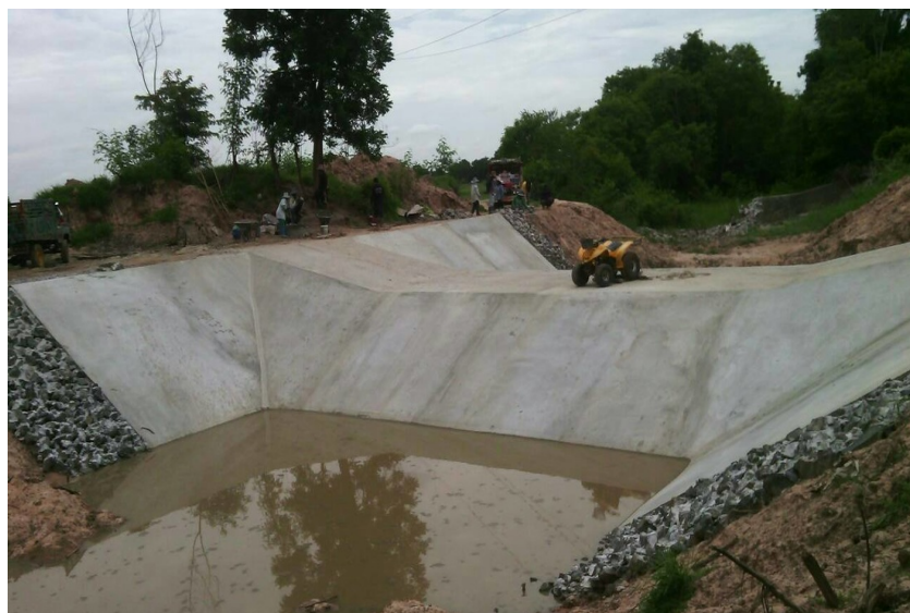
ภาพที่ 4 ถนนสำหรับน้ำล้นผ่านดำเนินการแล้วเสร็จ
