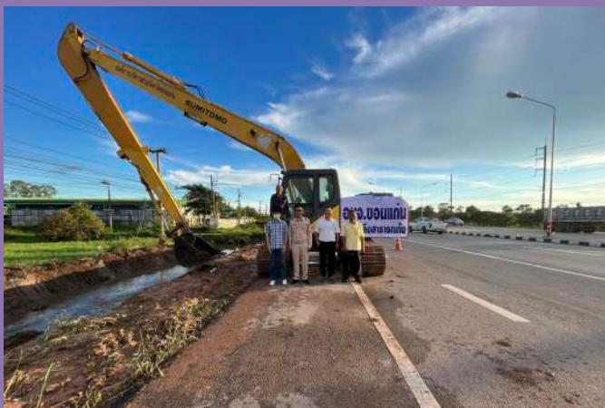
นำเครื่องจักรกลขุดดินตะขบ ไปดำเนินการขุดลอกเปิดทางระบายน้ำ เพื่อพร่องน้ำจากบึงหนองโคตรลงสู่ร่องระบายน้ำสาธารณะ บริเวณถนนเลี่ยงเมืองขอนแก่น
